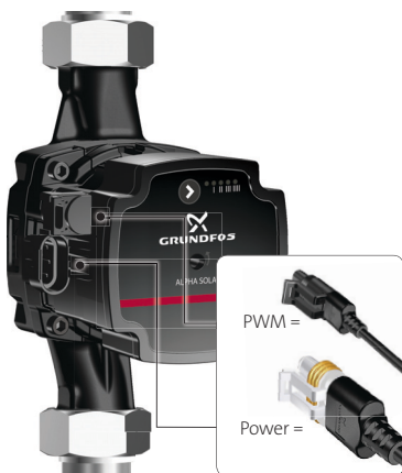
Obr. 32 Přípojky na elektronické jednotce
